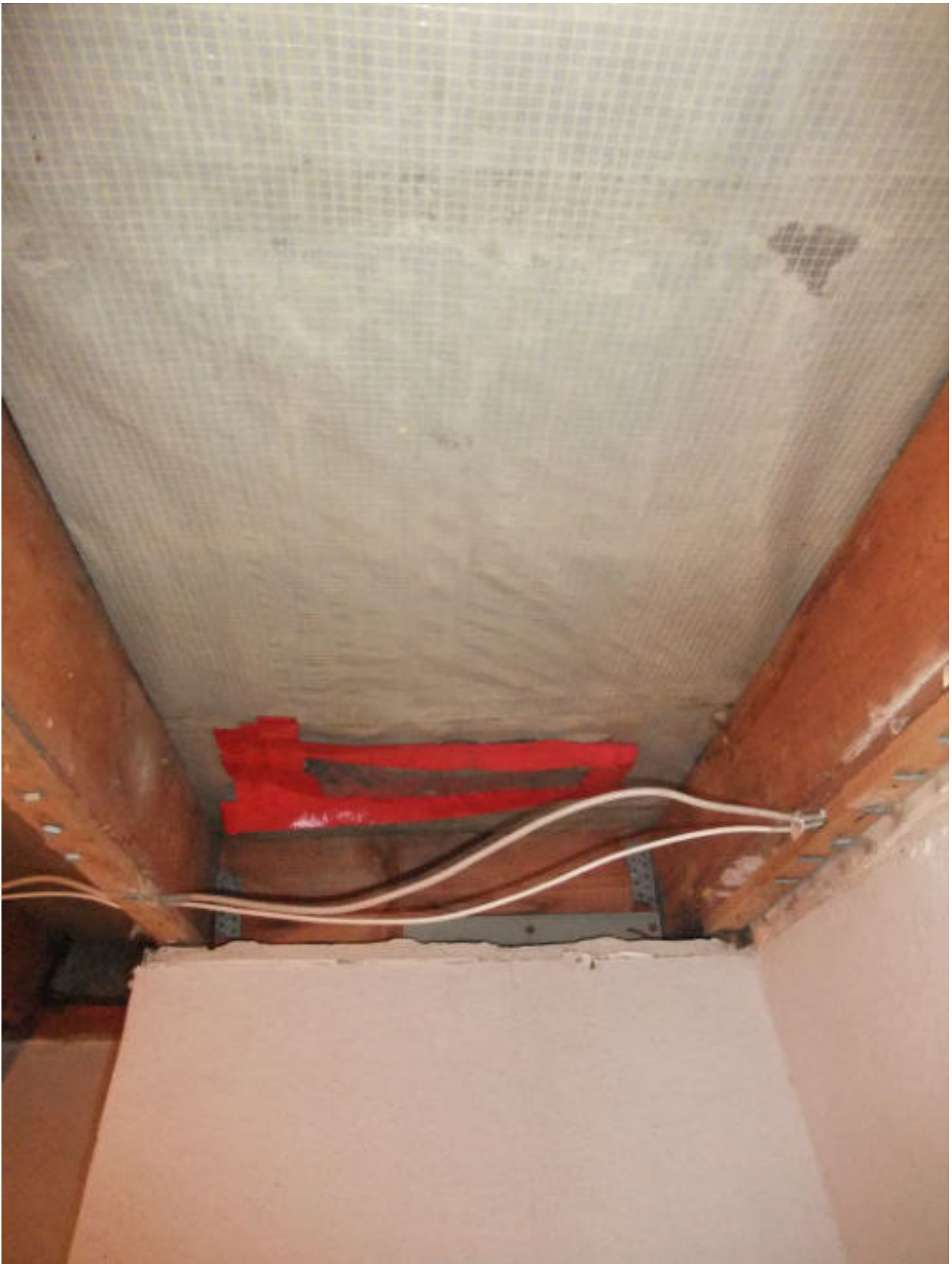
Oberhalb des Fensters, der andere Rest. Hier wurde mit Folie und rotem Klebeband die Unterspannfolie repariert. Darunter ist ein etwa 50cm x 20cm rechteckiger Ausschnitt in der Folie.
